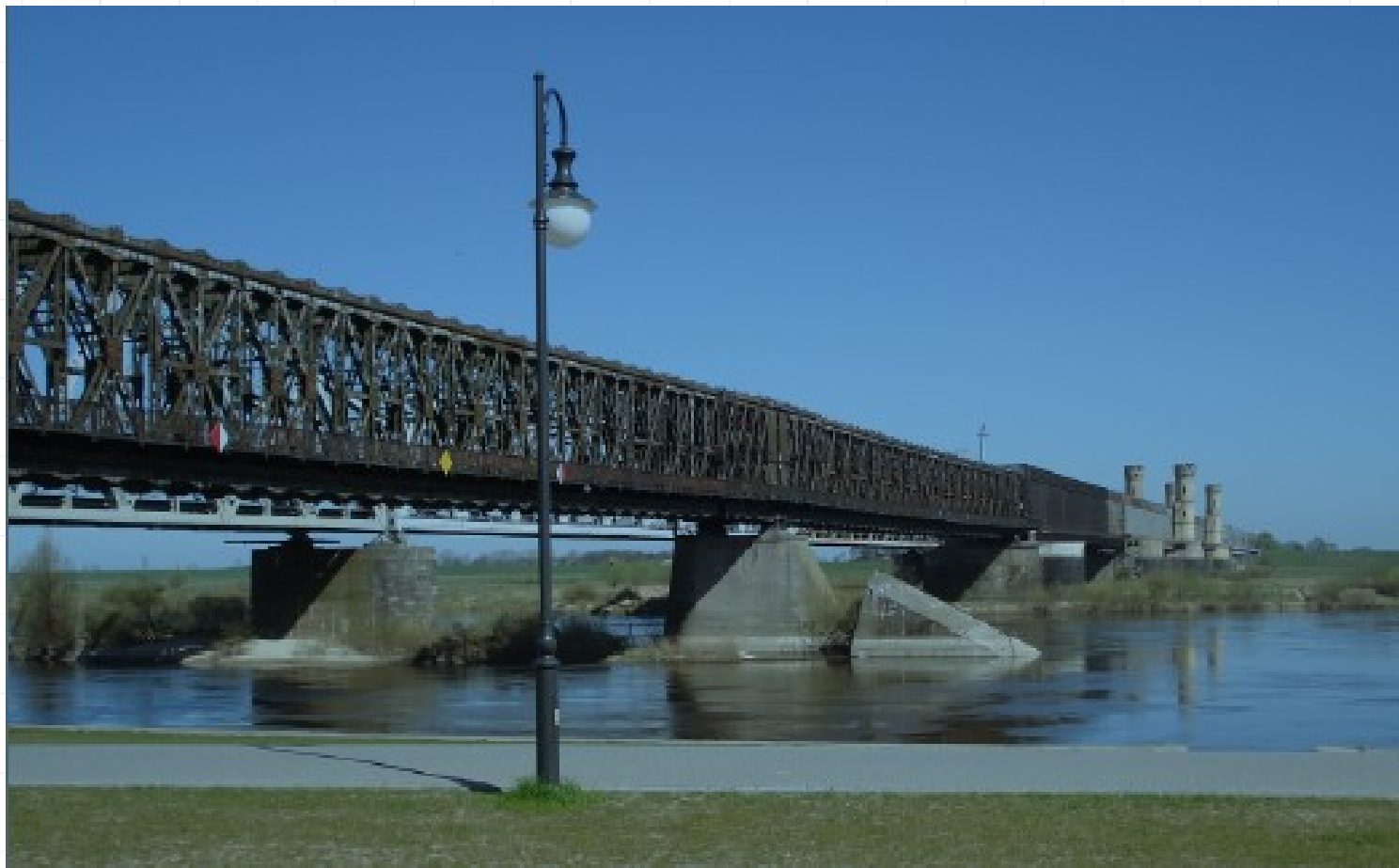
Rys. 1. Przykład kratownicy zastosowanej w budowie mostu
